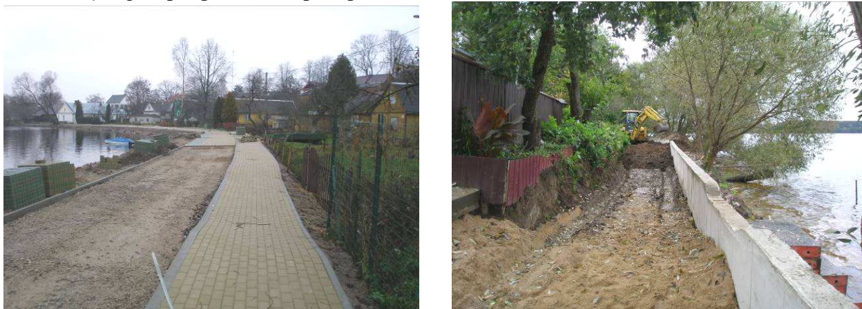
Vykdomi darbai Zaraso ežero pakrantėje.
