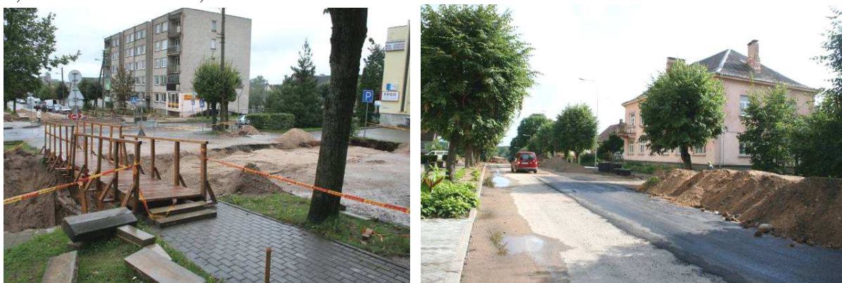
Rekonstruojamos Zarasų miesto Savanorių bei S. Dariaus ir S. Girėno gatvės
