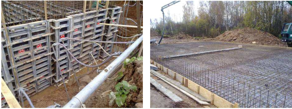
Dusetų nuotekų valyklos rekonstrukcijos darbai
