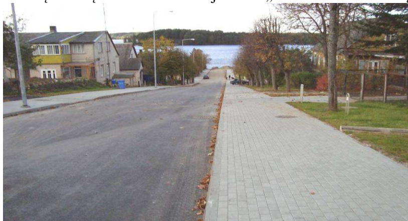
Užbaigta Zarasų m. Bajorų g. rekonstrukcija.
